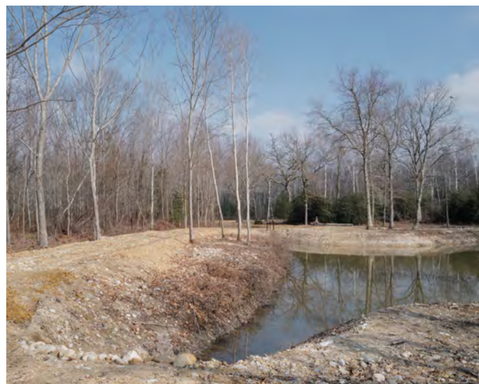
Le propriétaire a construit lui-même les aménagements routiers de sa forêt. © Bernard Rérat.
