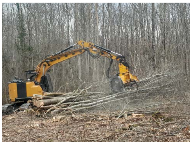
Époinçage au sol d'une javelle de bois énergie. DR.
